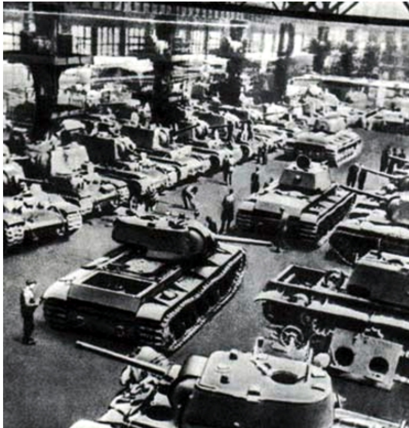
Figura 14-75. Cadena de montaje de una fábrica de de carros de combate de la Unión Soviética. El considerable esfuerzo de la industria bélica permitió a la URSS compensar los desastrosos primeros meses de la guerra.
