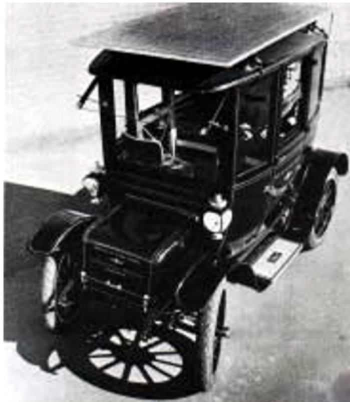
Figura 9-30. Sobre una réplica del Baker eléctrico de 1912 se realizó en 1960 este automóvil que empleaba la energía solar para producir
