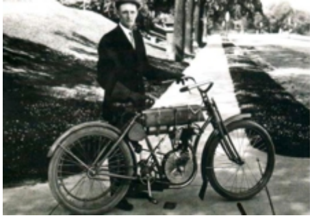
Figura 12-26. Davidson con su primera motocicleta. Figura 12-27. Primera motocicleta fabricada por HD, monocilíndrico, 160 cc y 3 HP, fabricada en 1903
