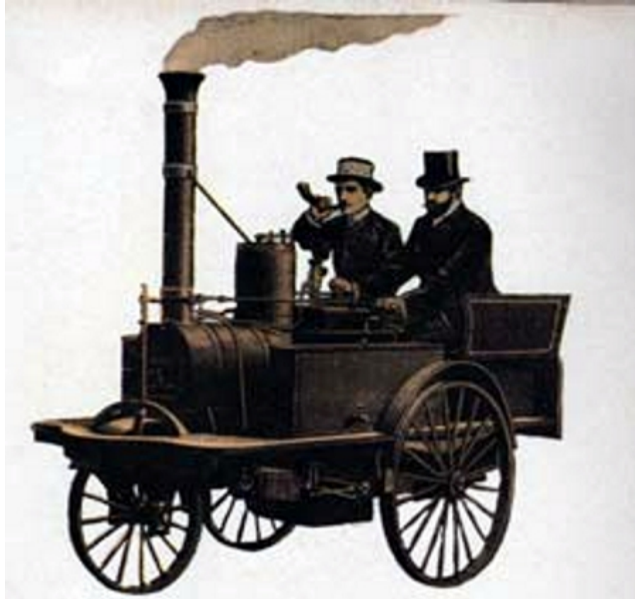
Figura 3-35. Virot a bordo de su vehículo a vapor que alcanzaba una velocidad de 16 km/h y superaba pendientes hasta de 8%. Fuente: Pininfarina (1967)
